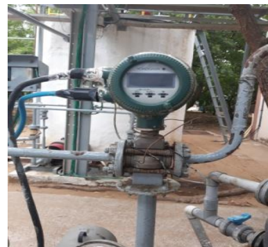
STP output flow meter
